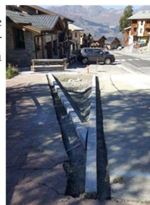
Remplacement de séparateurs bois par des bordures à Plan Peisey
